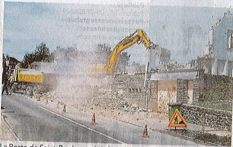
La Poste de Saint-Pardoux a été démolie mardi 19 avril.
