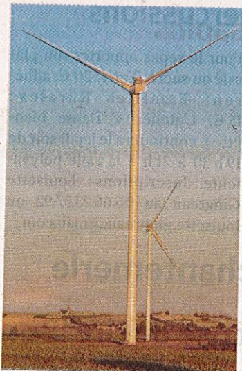
Les opposants redoutent notamment l'impact de ces éoliennes sur le paysage.
